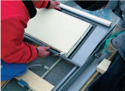
Montage der steckfertig verrohrten QUICK STEP®-Solar-Paneele
